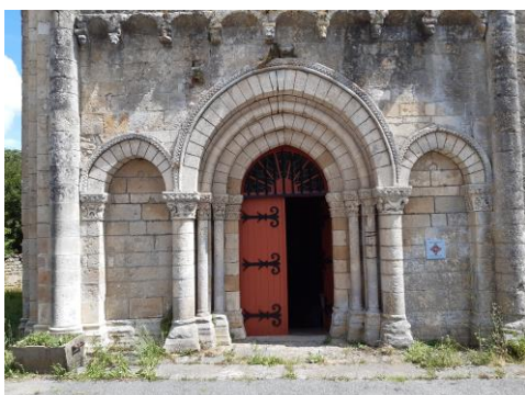
Portail d'entrée et détails des chapiteaux des voissures
